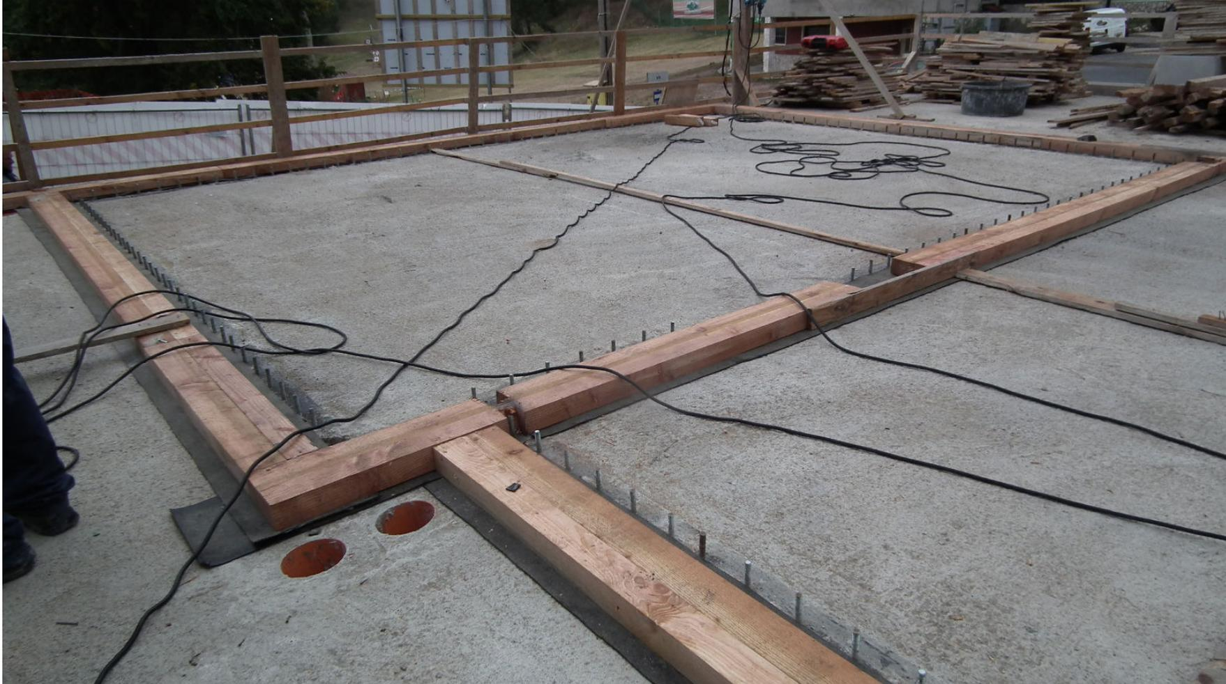
**TRACCIATURA E POSIZIONAMENTO TRAVI DI BASE IN LARICE**
